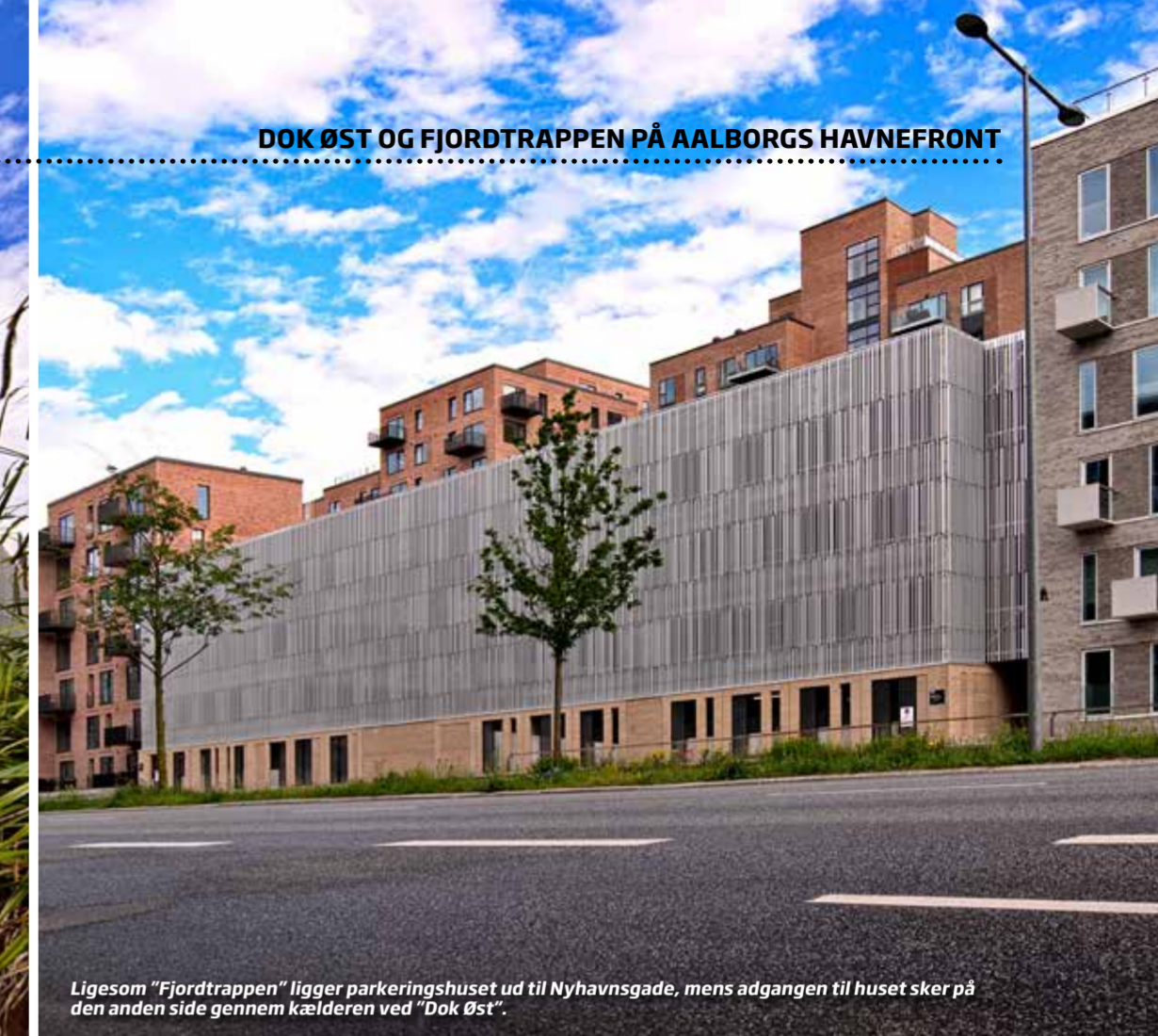
På størstedelen af parkeringshusets facade er der monteret lodrette aluminiumsprofiler, mens den nederste del består af teglsten og åbne felter samt strækmetal.
