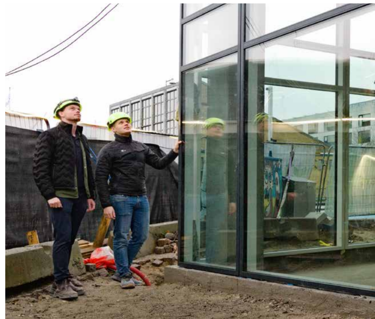
Jannik Mose Skov og Anders Christensen er begge gået fra praktikanter til nu at være fastansatte projektledere hos HP Byg. Første gang, de arbejdede sammen, var på opførelsen af fire bolig-tårne – Kløverhaven i Kolding – og i dag har de ansvaret for opførelsen af det kommende B&B Hotels i Aalborg Centrum.
